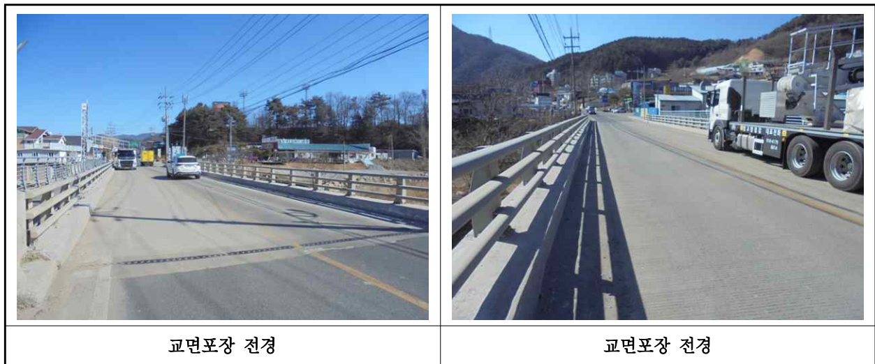
【사진 1.3.19】 교면포장 전경
