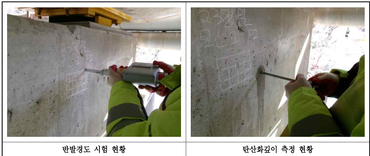
【사진 1.4.1】 콘크리트 내구성조사 현황
