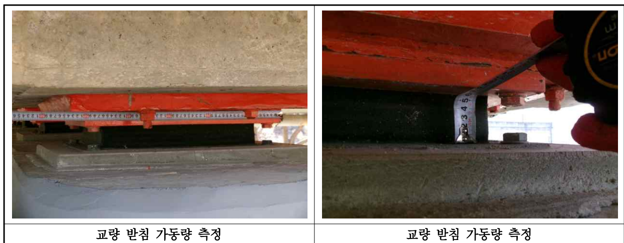
【사진 1.3.15】 교량받침 이동량 측정
