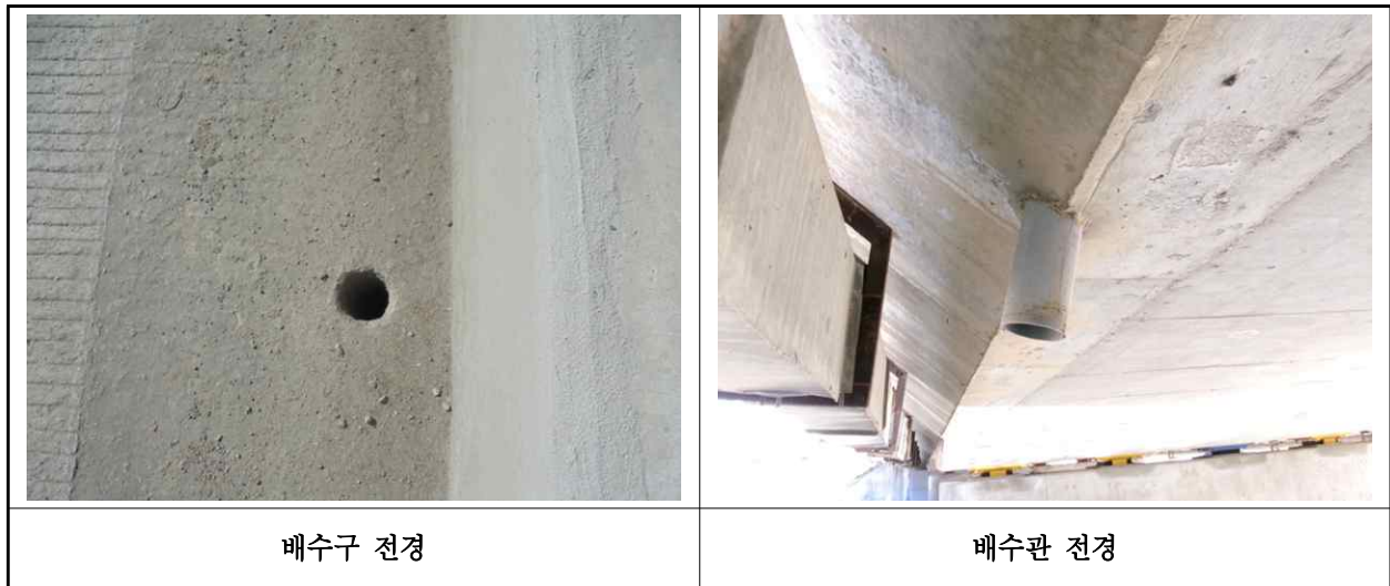
【사진 1.3.21】 배수시설 전경
