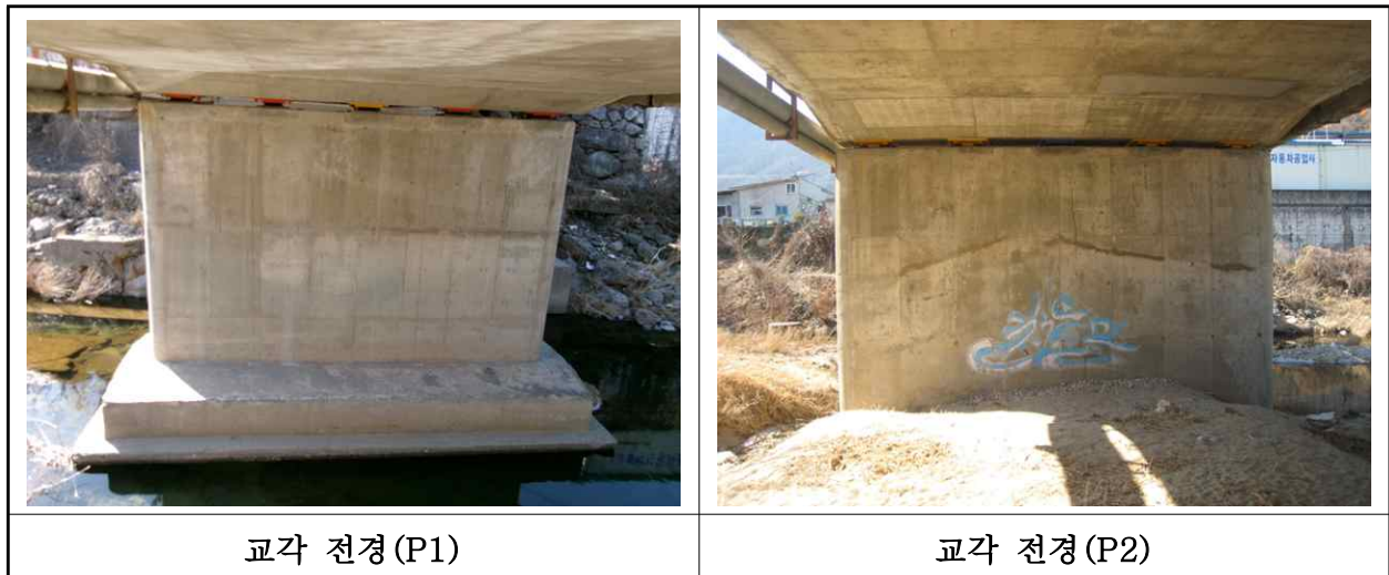
【사진 1.3.10】 교각 전경
