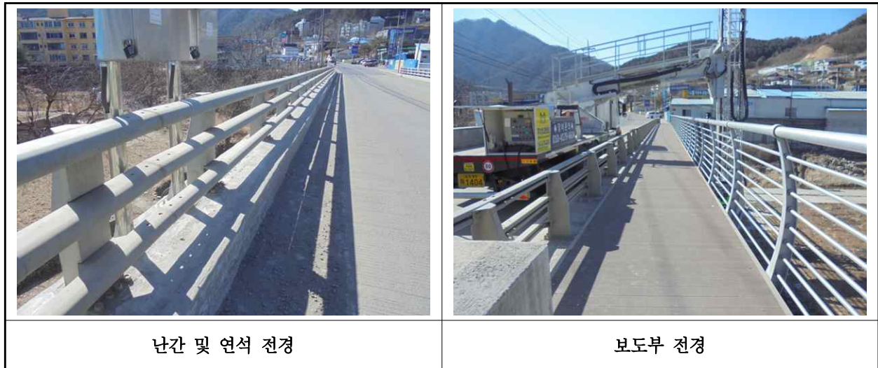
【사진 1.3.23】 난간 및 연석 전경
