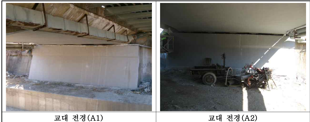
【사진 1.3.8】 교대 전경
